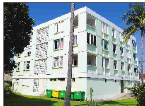
Cet ancien immeuble de Ravine-Blanche illustre bien la « culture du bunker » que dénonce l'architecte.
