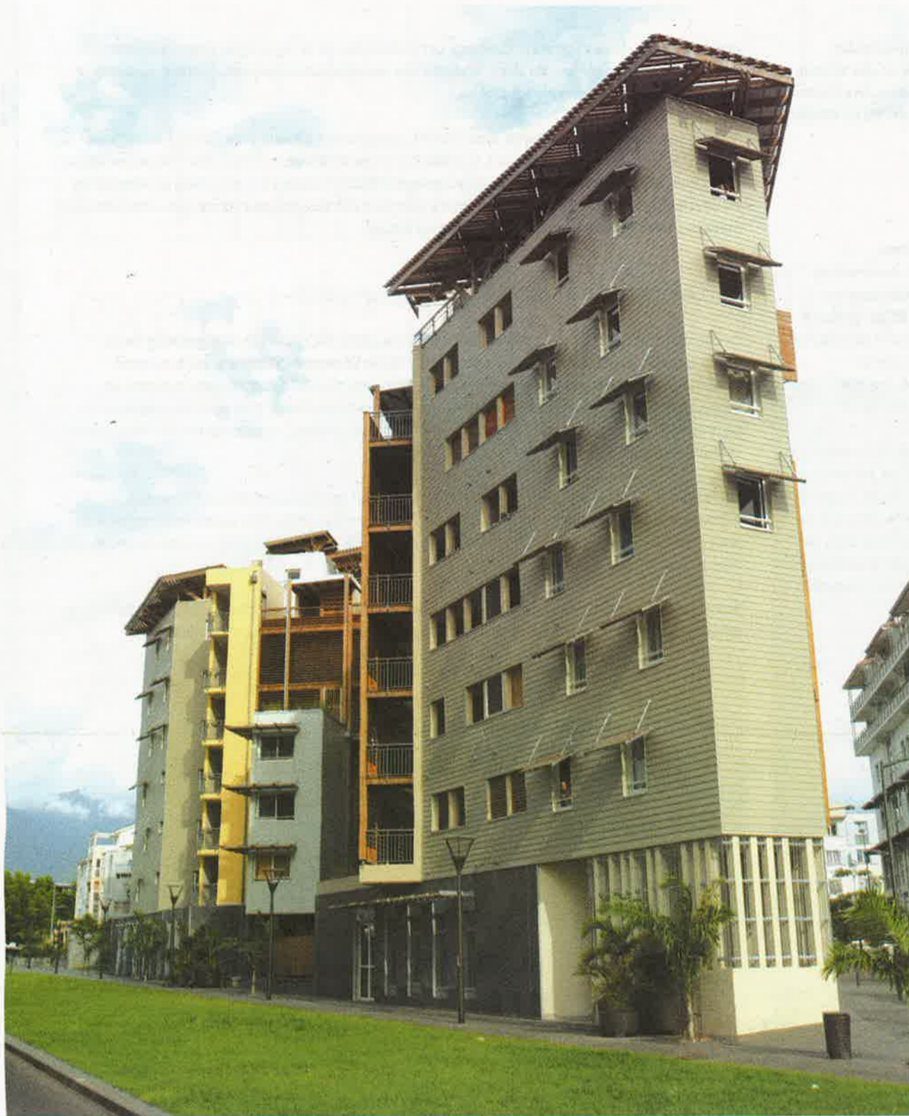
Entre les deux immeuble, le mail. Un espace vert en pleine terre pour faciliter l'infiltration des eaux de pluie.
