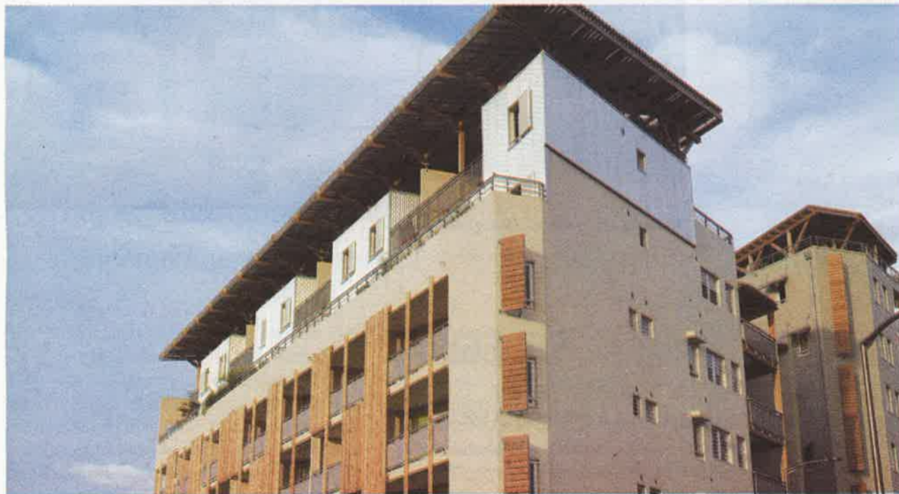
Au dernier étage, des «cases créoles» dont la tôle ondulée est en réalité de l'ondulit, matériau qui rejette la chaleur. Au-dessus des panneaux photovoltaïques qui permettent aussi une meilleure isolation de l'immeuble qui est aussi une ferme solaire.
